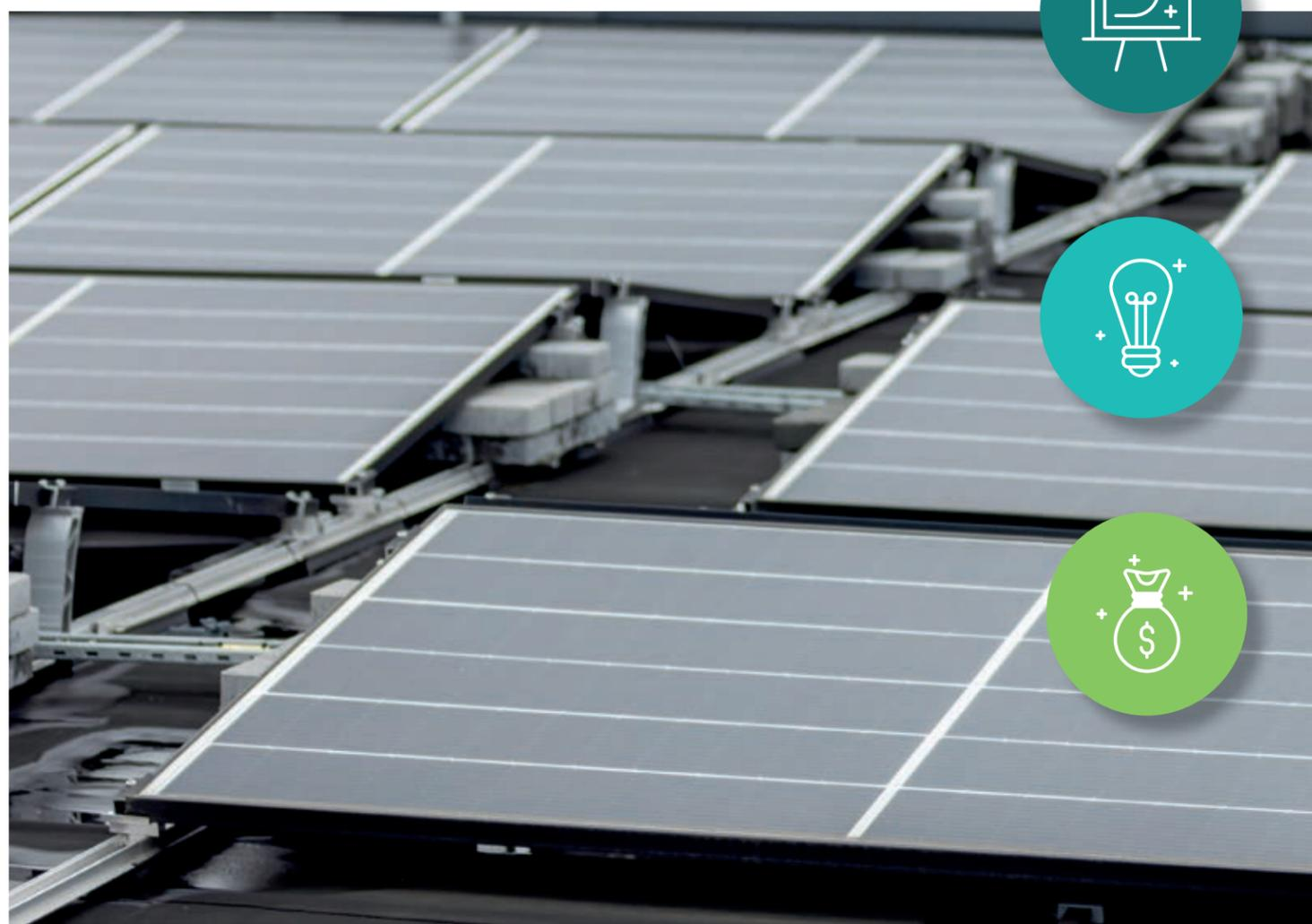
Tuvieron que impermeabilizar los techos de todas las naves, así como también se consultó al Instituto de la Seguridad de las Construcciones sobre el tipo de construcción y las bases para los paneles solares para evitar algún problema estructural. Se instalaron más de 30 mil paneles solares de energía sobre una superficie de 20 hectáreas para la Central de Abasto con las que se produciría energía eléctrica equivalente a 10 mil hogares en las áreas comunes de este mercado.
